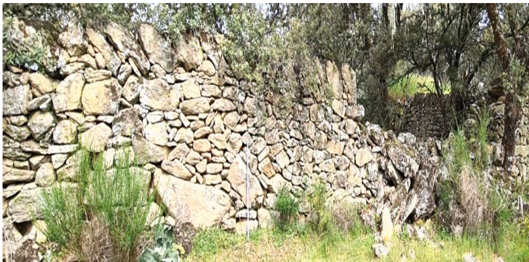
Fig. 4. Muro de mampostería apoyado sobre piedras de gran tamaño
