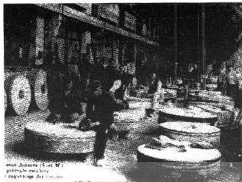
Fig. 10. Taller de preparación de las muelas de la Société Générale de la Ferté—sous Jouarre—. (Cortesía d'Amis des Moulins d'Île de France).
